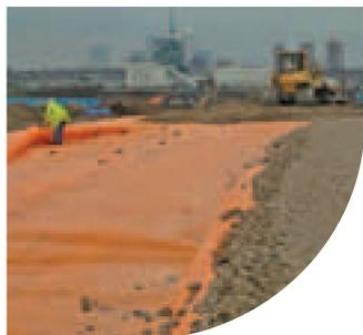
**TERRAM™ Hi-Vis est un géotextile non-tissé orange utilisé pour séparer les sols contaminés des sols non contaminés.**
