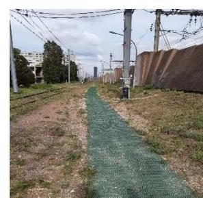
Pose d'un géotextile monofilament Thermo-lié WEEDGUARD UV+ 125 g/m2 et d'une grille GRASSPROTECTA HEAVY 14KN sur la moitié du cheminement et un géotextile anti-germinatif AMTEX SP6 150 g/m2 et une grille GRASSPROTECTA Medium 11KN jusqu'au poste.
