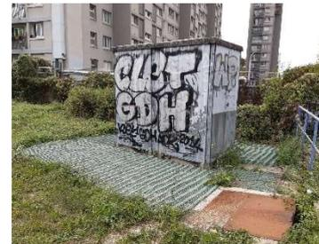
Pose d'un géotextile monofilament Thermo-lié ROOTGUARD UV+ 260 g/m2 tout autour du poste. Un second géotextile anti-germinatif AMTEX SP6 150 g/m2 sera superposé sur 1ml à l'arrière du poste situé à proximité des barbelés afin d'essayer de mieux contenir les ronces. Puis pose d'une grille GRASSPROTECTA HEAVY 14KN sur toute la surface
