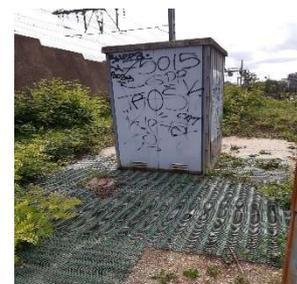
Pose d'un géotextile anti-germinatif AMTEX SP6 150 g/m2 et d'une grille GRASSPROTECTA MEDIUM 11KN sur le devant du poste et un géotextile anti-germinatif AMTEX SP6 150 g/m2 sous 2 cm de sable à l'arrière du poste.
